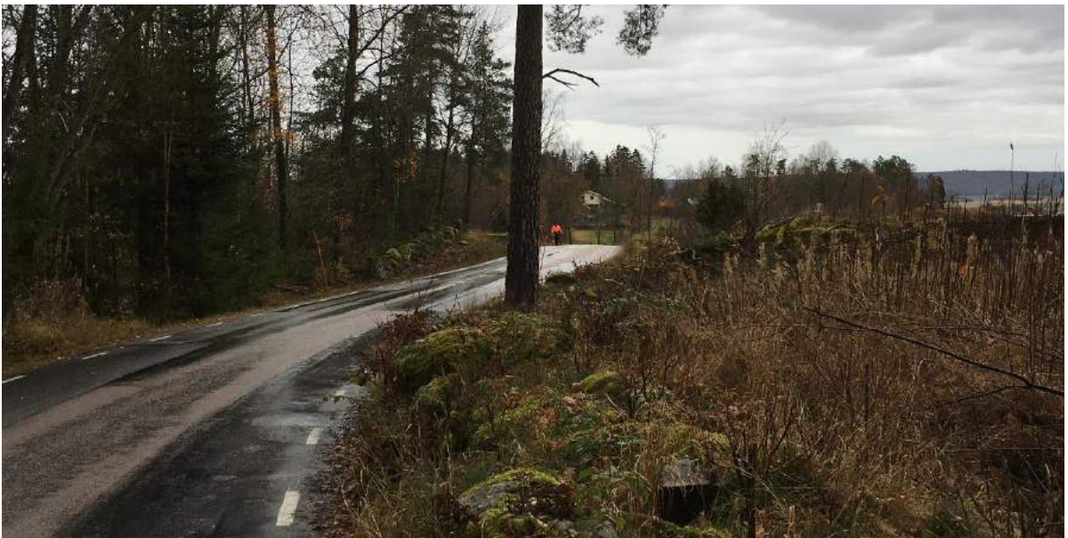
Bild som visar sikt norrut från föreslagen passage över Hullsjövägen. Tallen mitt i bilden kommer att tas ner. 110 meter sikt går att uppnå.
