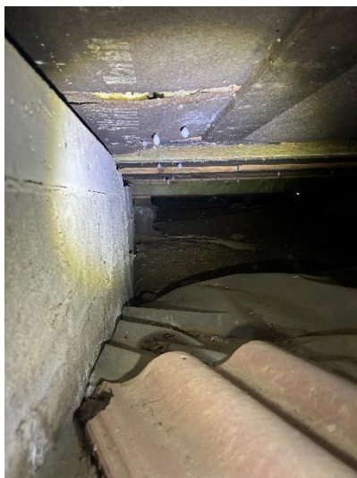
Torpargrunden, besiktigat från öppning pga låg höjd, mycket spindelkokonger och något högt fuktvärden vid besiktningsstillfället.
