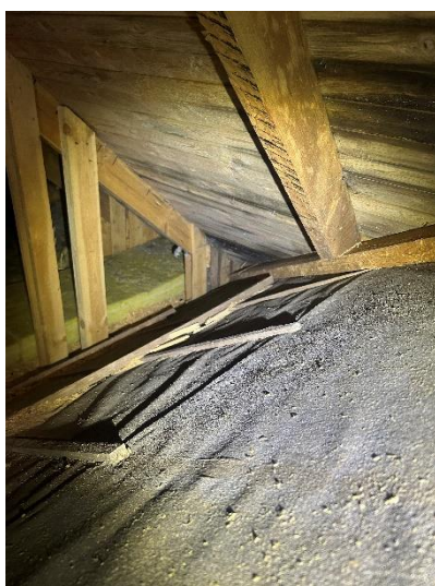
Underlagstaket pånockvinden har missfärgningar/fuktgenomslag och mikrobiellpåväxt.
