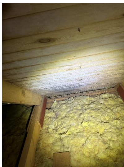
Underlagstaket pånockvinden har missfärgningar/fuktgenomslag och mikrobiellpåväxt.
