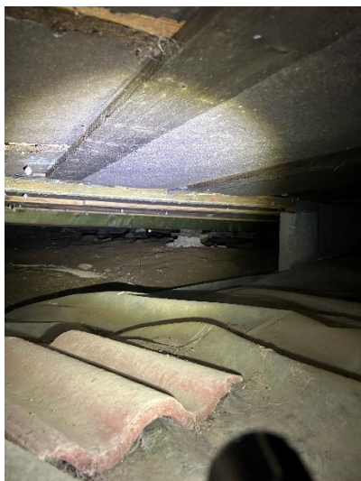
Torpargrunden, besiktigat från öppning pga låg höjd, mycket spindelkokonger och något högt fuktvärden vid besiktningsstillfället.
